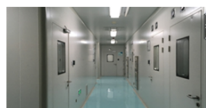
负压二级生物安全实验室
